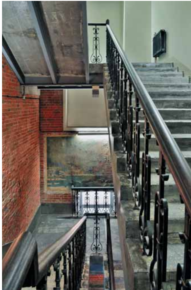
Лестницы – на вставленные металлические балки с косоурами опираются лестничные марши из монолита; ограждения кованые, с дубовыми перилами. На заднем плане – полусохранившаяся фреска сталинских времен.
