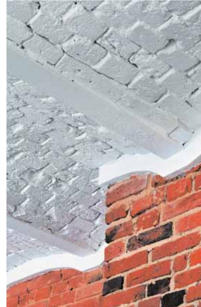
Примыкание сводов Монье к стене. Цветовой контраст / фактурная родственность.
