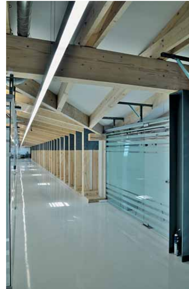
Опен-спейс мансардного этажа с отрежиссированной атмосферой лофта – верхний свет, открытая в интерьер стропильная конструкция из клееной сосны, усиливающие детали из некрашеного металла.
