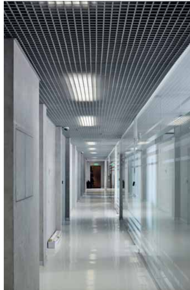
Коридор на 3-м этаже. Оштукатуренные стены с затиркой под бетон, перегородки из сатинированного стекла, наливные полы и решетчатый потолок от «Хантер Даглас» создают стерильно-офисную атмосферу.
